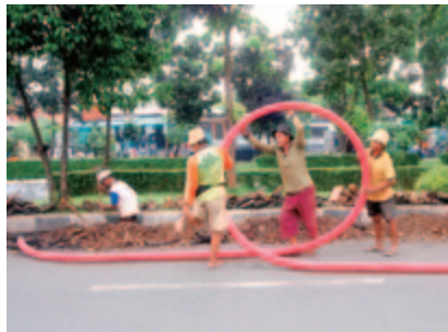
電力ケーブル
