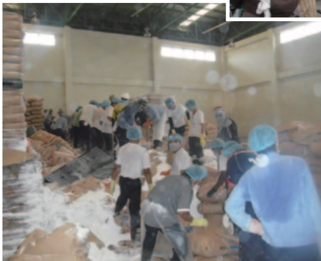
倉庫の復旧作業
