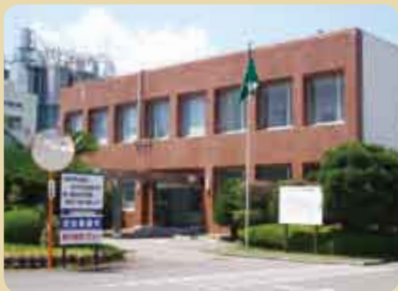
三重工場事務所正面
